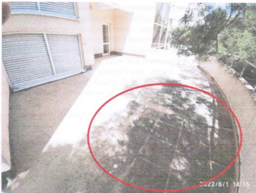
Фото 2. Застой воды, отсутствие слива с балкона. Далее вода попадет через слои в перекрытие.
