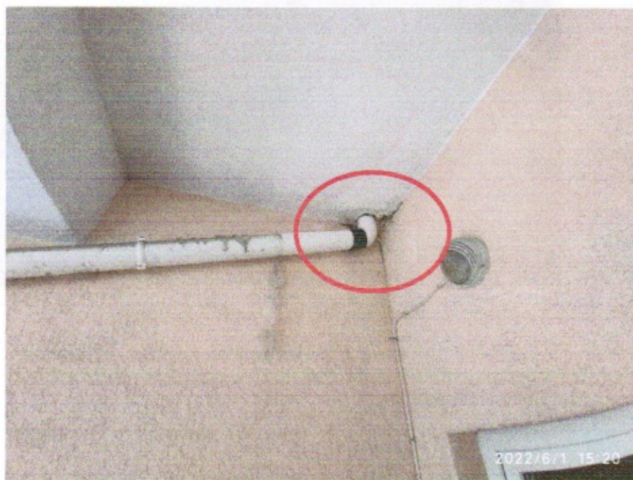
Фото 5. Протекание в районе прохода водосточной трубы через перекрытие 1-го этажа.
