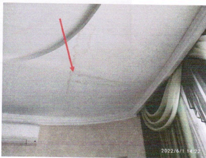
Фото 12. Следы намокания потолка в кухне.
