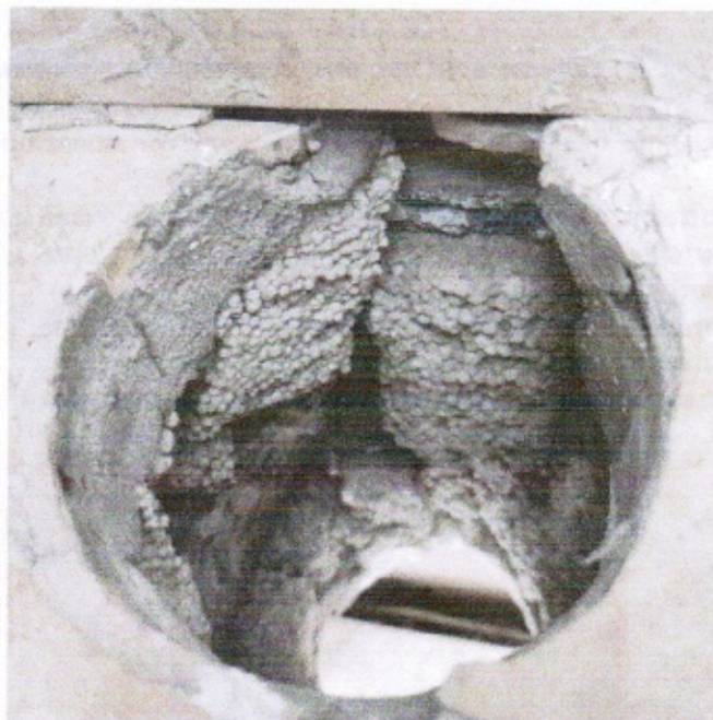
Фото 14. Состав балконной плиты - легко водопроницаемые негерметичные материалы.
