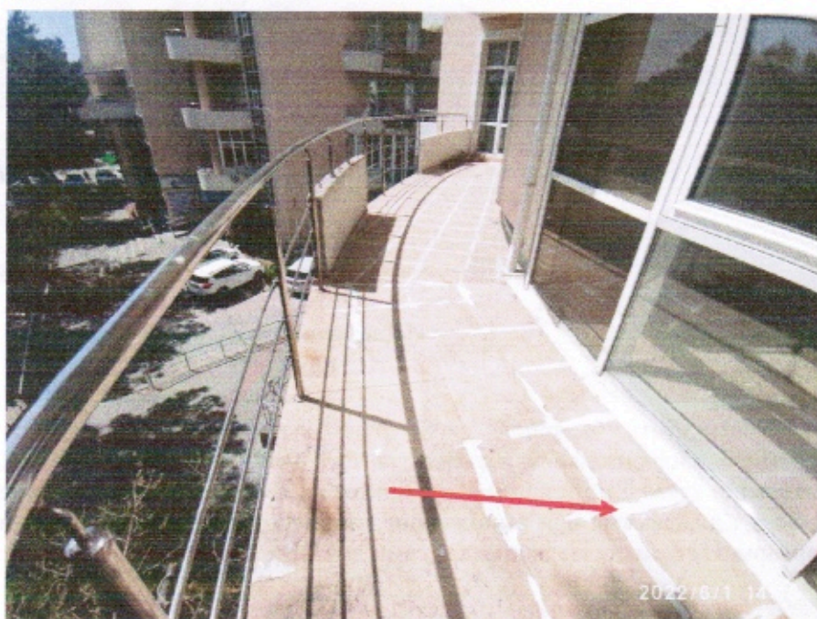
Фото 3. Белым герметиком предпринимаются попытки устранить протекание через швы плитки.
