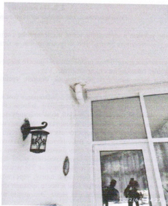
Фото 11. Место затопления балкона – проход водосточной трубы дома через балкон 3-го этажа.
